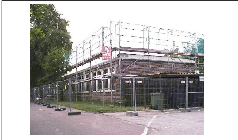
Abb.3: Umbauarbeiten im Jahre 2007
